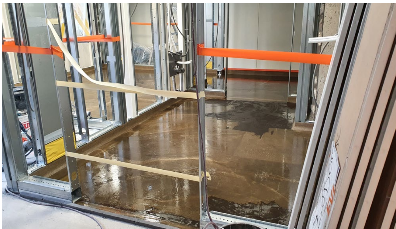
Bygget kom igång under våren 2022 och den processen genomfördes utan större komplikationer och i stort sett enligt tidsplan.
