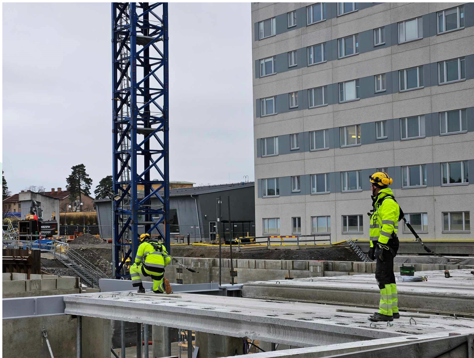
På bilden monteras akutmottagningens golv.
