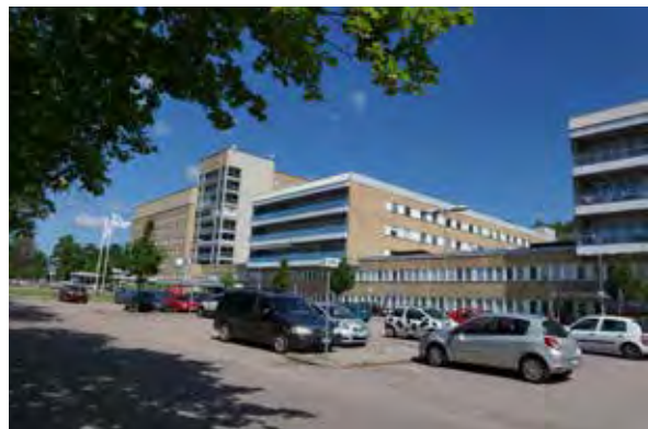
De två nya låga vårdbyggnaderna invigda 1974. Här fanns nya vårdavdelningar som var moderna enligt dåtidens krav. Foto: Gunilla Kullinger.
