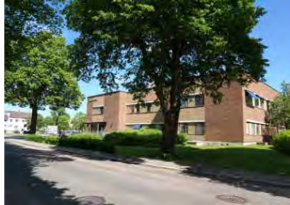
Vårdcentralen i hus 01, 02 och 03 vid Västmanlands sjukhus Köping. Foto: Gunilla Kullinger.
